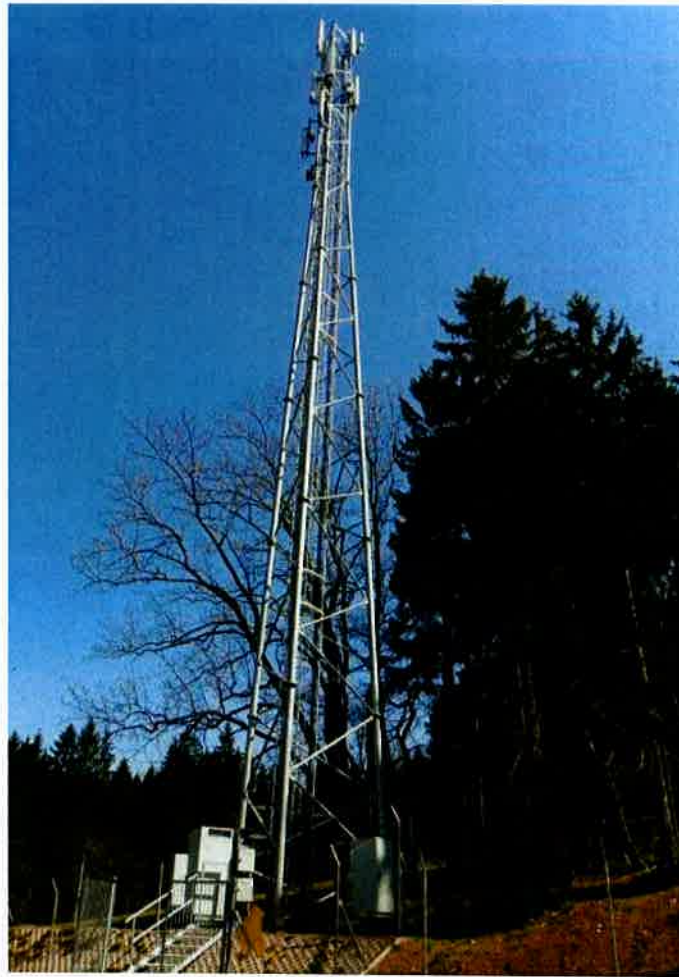
Fot. 1. TSR Sokołowsko / Polana – widok obiektu
