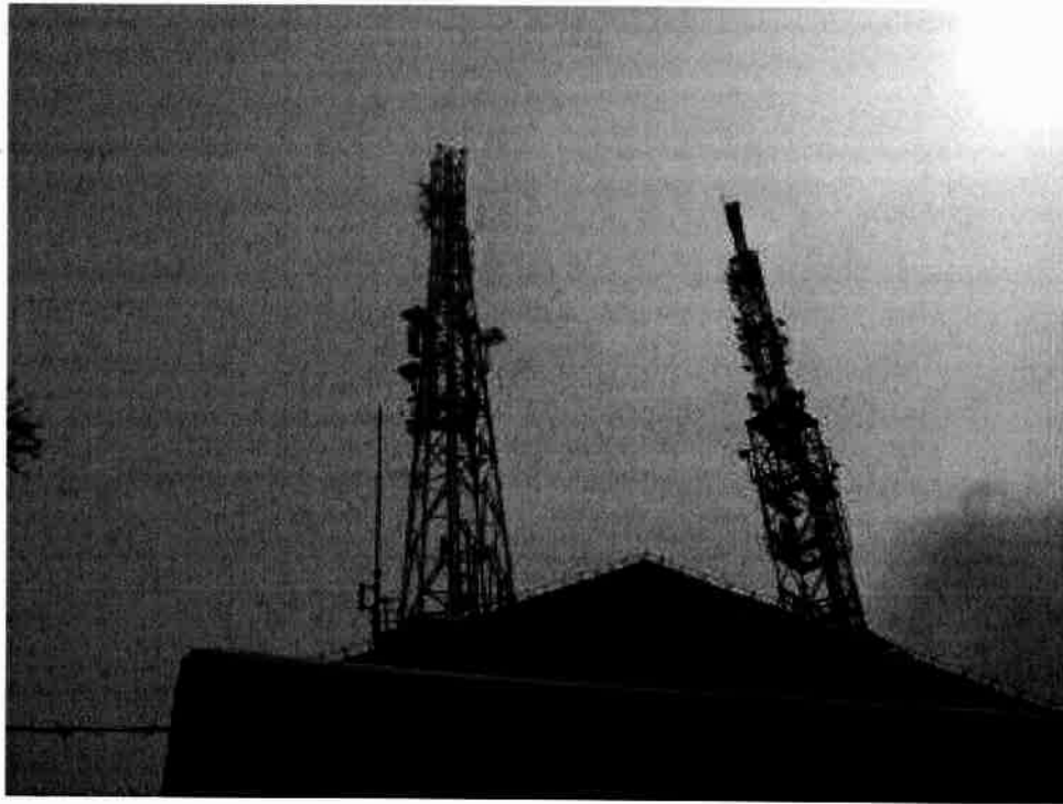
Fot. 1. RTON Wałbrzych Chełmiec – widok obiektu
