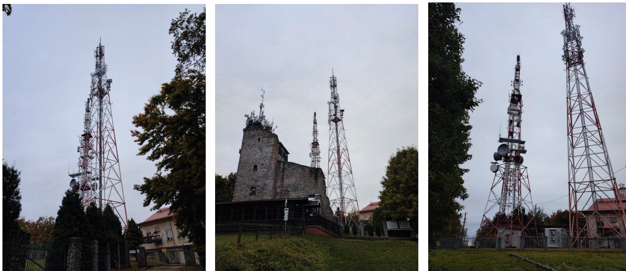
Widok obiektu wraz z zainstalowanym zespołem antenowym
