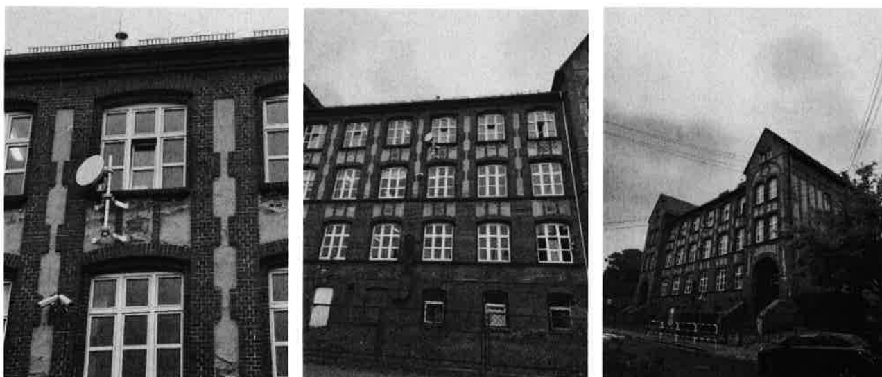
Widok obiektu wraz z zainstalowanym zespołem antenowym
