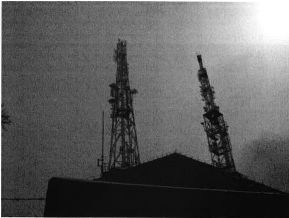
Fot. 1. RTON Wałbrzych Chełmiec – widok obiektu
